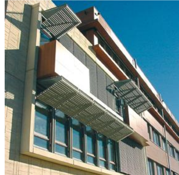
Drehschiebläden in hochgefahrener und geschlossener Position
